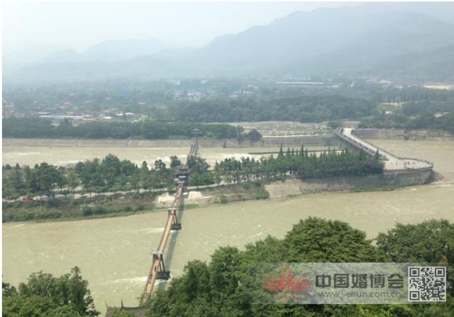
Der Wasserteiler von Dujiangyan zur Bewässerung der Ebene von Chengdu (256-251 v. Chr. erbaut, 2006 modernisiert)
