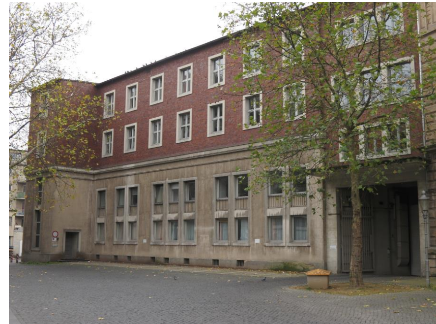
Ehemaliger Polizeibunker in der Münzstraße
