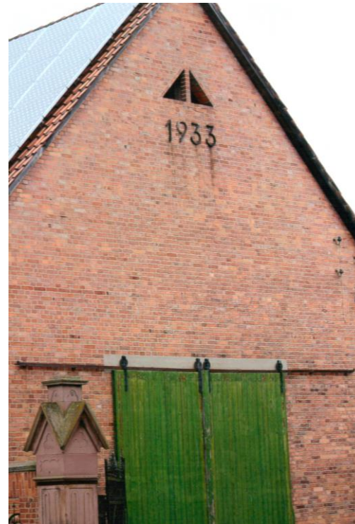
Stallgebäude Hof Lauenstein
