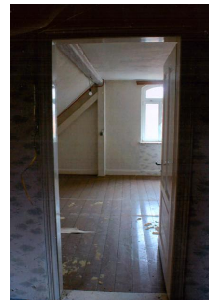
Dachkammer im Schulgebäude
