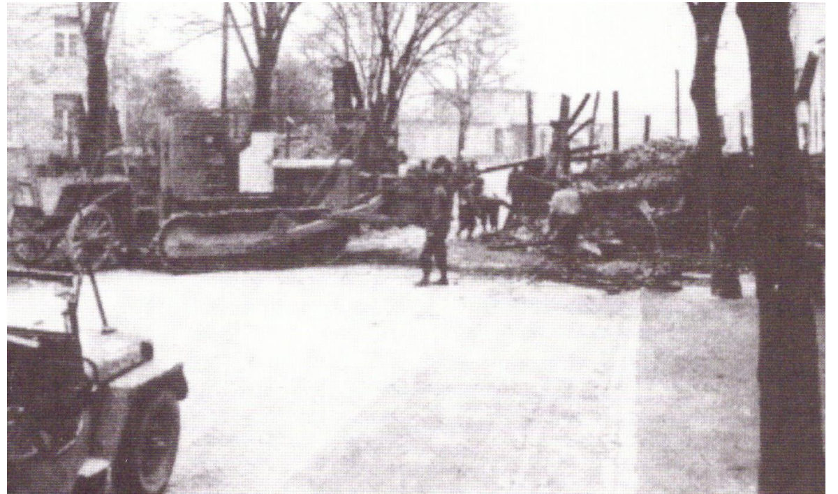
Amerikanisches Räumfahrzeug beseitigt Barrikade auf der Hildesheimer Straße
