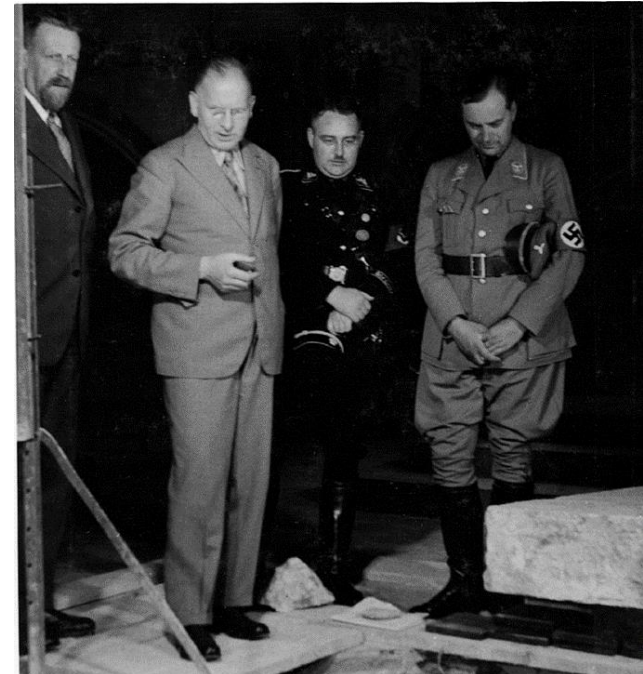
Fischer, Hofmeister, Klagges und Rosenberg an der geöffneten Gruft am 29.6.1935
