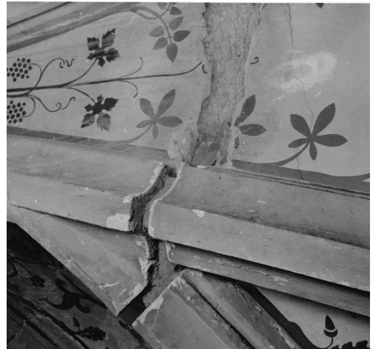
Risse im Gewölbe des nördlichen Seitenschiffs
