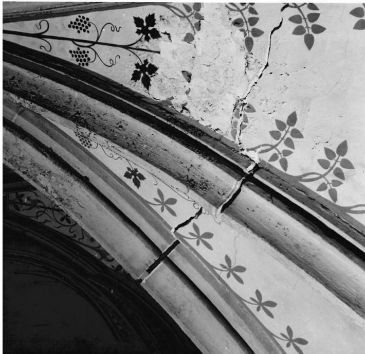
Risse im Gewölbe des nördlichen Seitenschiffs
