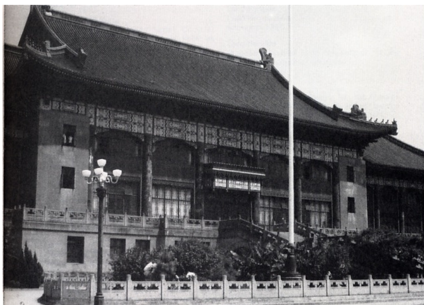
Ehemaliges Rathaus der Stadtverwaltung von Großshanghai, gebaut 1934. (Foto U. Menzel, 1992)
